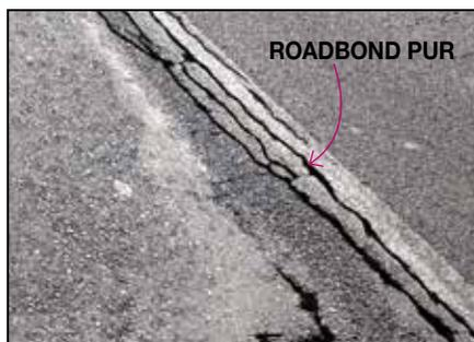
Considerando che il mastice ha una massa volumica (densità) di 1 kg/dm<sup>3</sup> ca. per la sigillatura di una fessura di 1 cm<sup>2</sup> di sezione si consumano 0,1 kg per metro di lunghezza.
