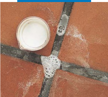
Pulizia di efflorescenza
