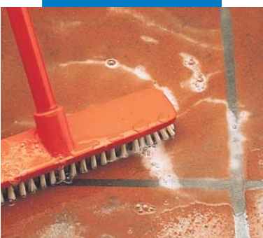
Pulizia con Keranet Liquido con spazzolone
