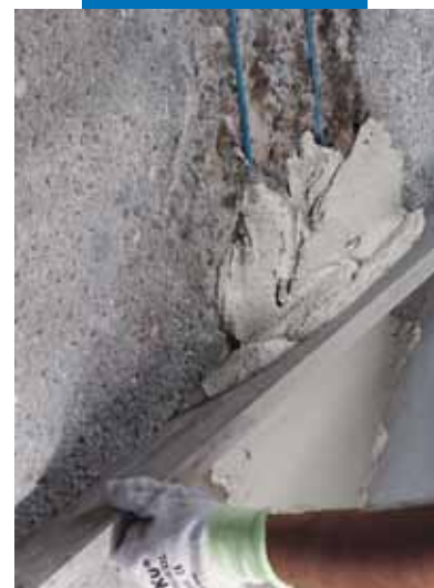
Staggiatura di Planitop Rasa & Ripara
