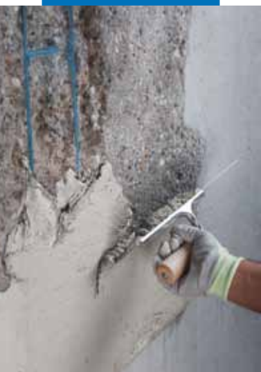
Applicazione a spatola di Planitop Rasa & Ripara
