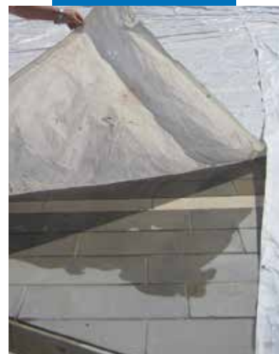
Esempio di protezione della pavimentazione
