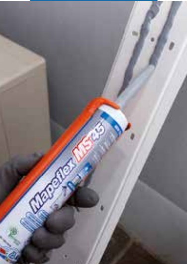
Incollaggio di profili in plastica in esterno
